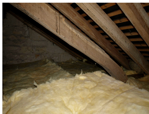
Isolation sous la toiture
