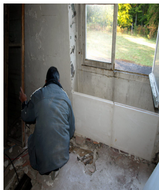
Fenêtre avant / pendant / après fermeture avec des carreaux de plâtre
