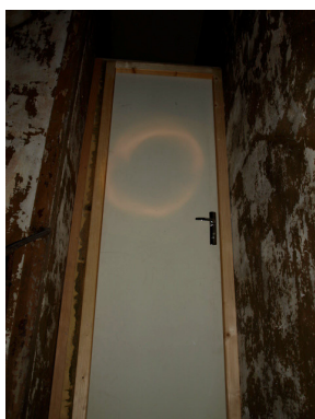
Pose d'une porte pour compartimer les combles du reste de la MF
