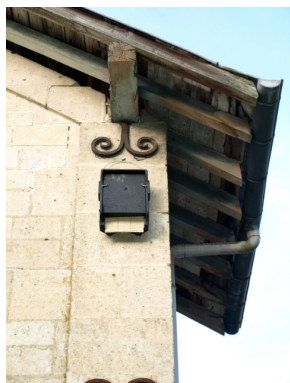
Pose d'un gîte artificiel en façade
